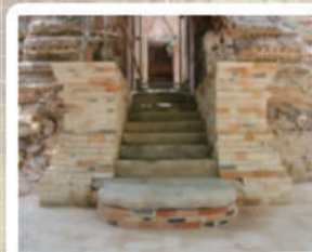
テラスの修復作業前の説明と作業完成後
