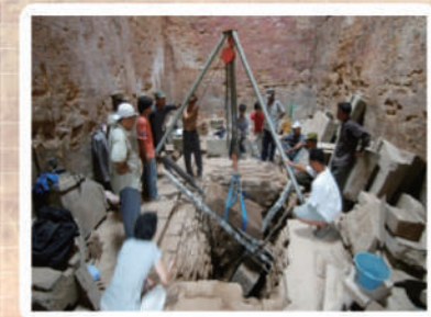
寺院内部の修復
